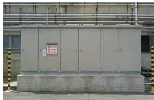
トップランナー変圧器へ更新の例
