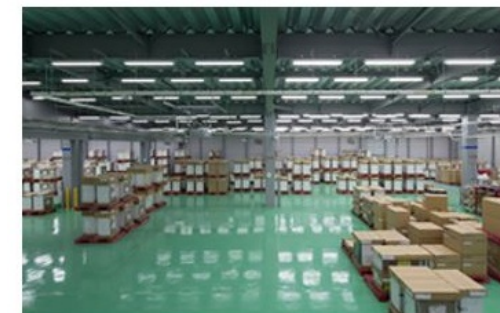
工場内に設置したLED照明器具の例
