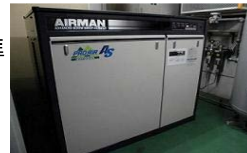
最新のコンプレッサーへ更新の例
