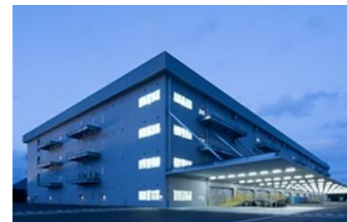
物流棟全体の照度を一元管理の例
