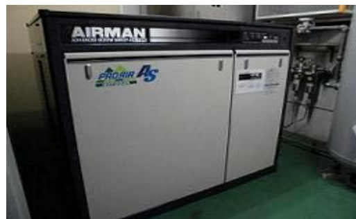
最新のコンプレッサーへ更新の例
