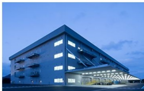
物流棟のLED照明5,000台を点灯エリアやの照度を1台ごとに設定でき、管理室で一元管理
