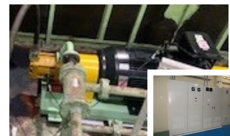
高効率油圧式モーターと INV制御の組合せ例
