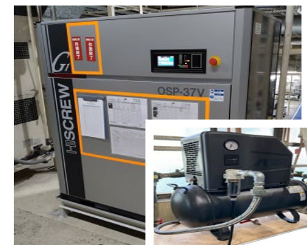
最新のコンプレッサー（高効率 トップランナー仕様）へ更新の例
