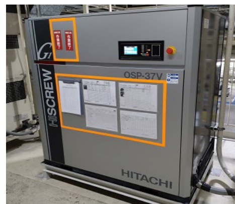
コンプレッサーの高効率化の例 (見える化システム搭載)
