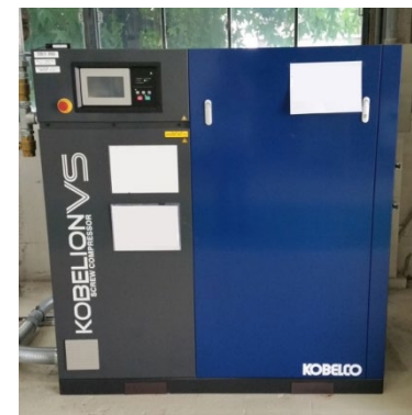
コンプレッサーへ更新（高効率、見える化システム搭載）の例
